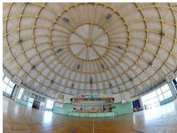
写真 体育館棟の屋根の鉄骨組
